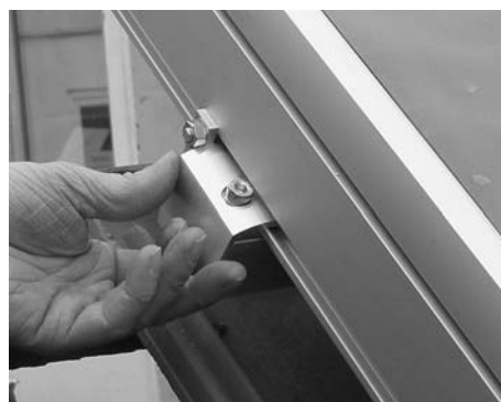
Posición correcta de una pinza lateral izquierda
