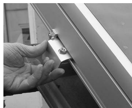
Posición correcta de una pinza lateral izquierda
