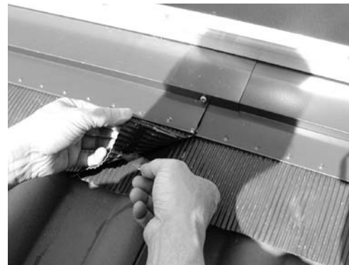
Retire las bandas protectoras y presione fuerte las chapas de plomo
