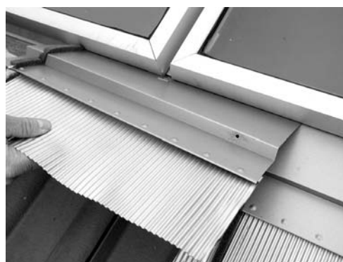
Colocación del conector intermedio de las chapas de plomo (BSM)
