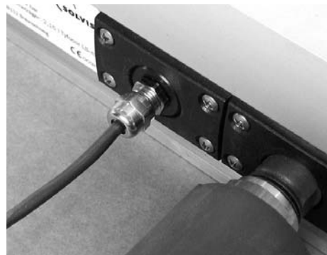
Sensor introducido hasta el tope y atornillado
