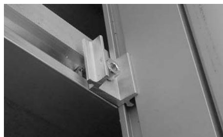
Primero afloje las pinzas intermedias ligeramente
