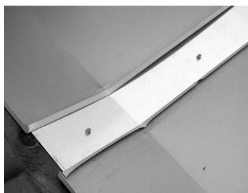
Parte inferior del conector de la chapa superior colocada, siguiente chapa superior por encima
