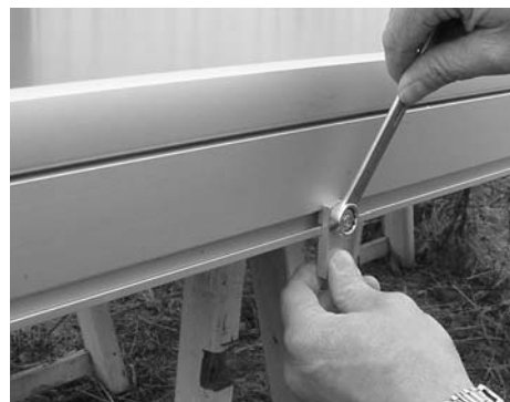
Colocación de un tope
