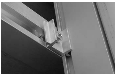
Primero afloje las pinzas intermedias ligeramente
