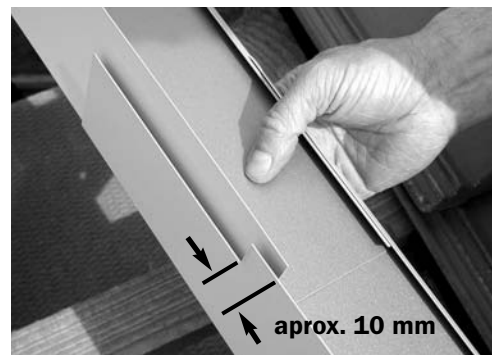
Encaje las chapas laterales
