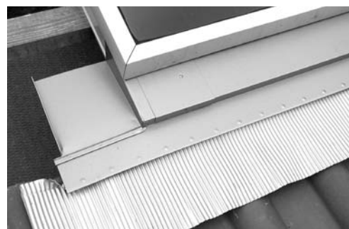
Chapa de plomo izquierda (con esquina) colocada
