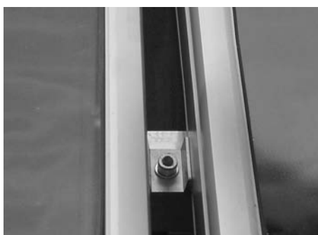
Segundo colector encajado en la pinza intermedia
