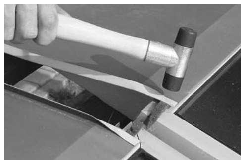
Si es necesario aplaste un poco el pliegue de la chapa superior
