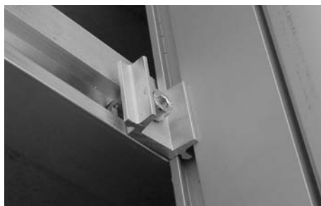
Primero afloje las pinzas intermedias ligeramente
