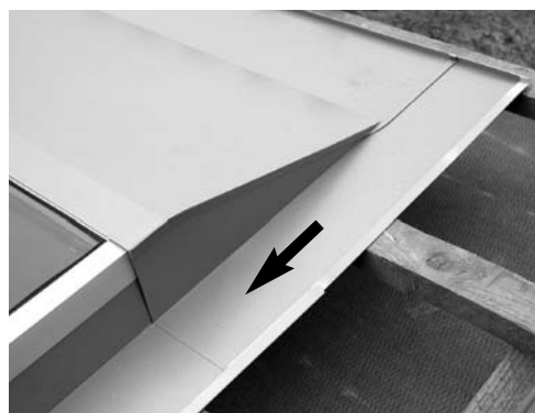
Introduzca la chapa superior derecha (con esquina) en la chapa lateral
