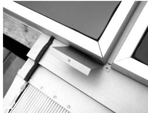
Colocación de la segunda fijación de chapas de plomo
