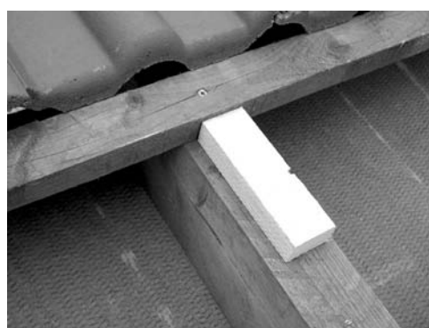
Refuerzos para debajo de la parte superior de la chapa superior
