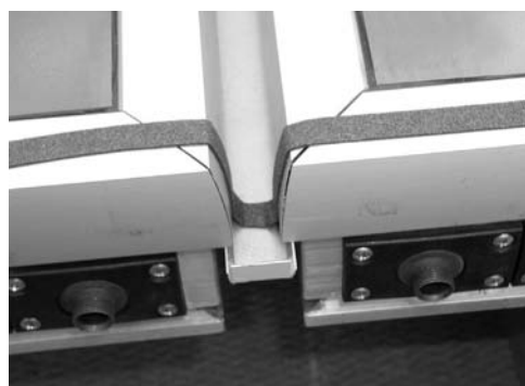
Pegue banda de estanqueidad también en la chapa de conexión
