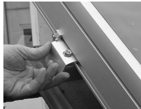
Posición correcta de una pinza lateral izquierda
