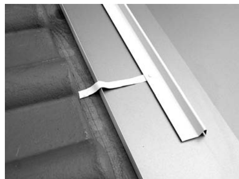
Alza para tejas colocada correctamente
