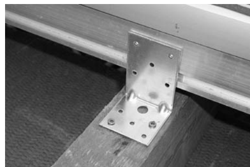
Atornille el colector por arriba
