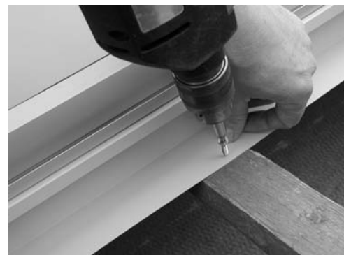
Atornillar la chapa de conexión
