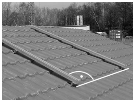
Rieles de sujeción ya montados
