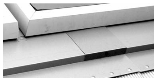
Atornille todas las chapas de plomo
