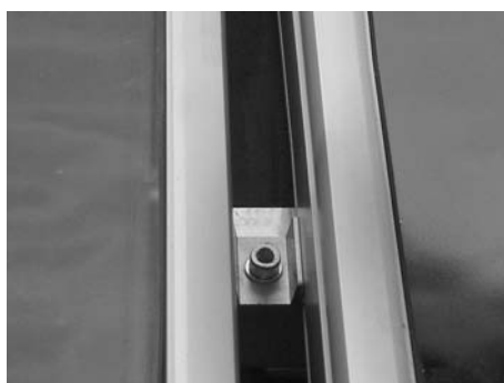
Segundo colector encajado en la pinza intermedia
