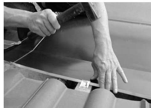
Fije arriba en el lado superior del colector las chapas superiores
