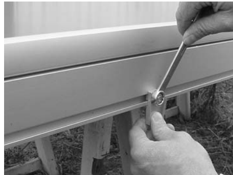
Colocación de un tope
