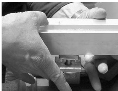
Inserte el tornillo de cabeza de martillo en el riel de sujeción
