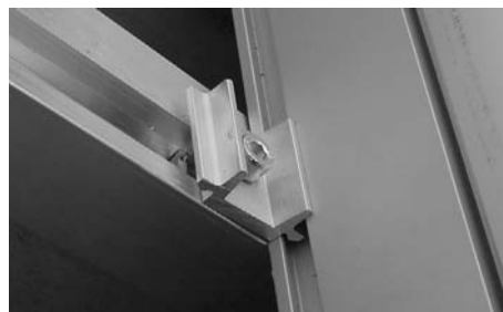
Primero afloje las pinzas intermedias ligeramente
